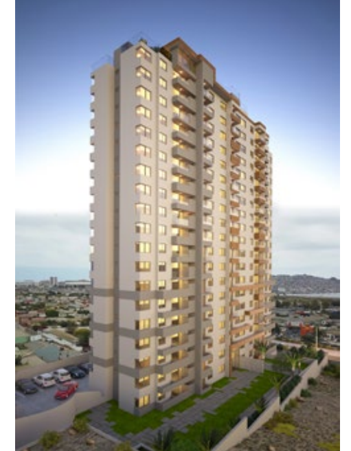
Edificio Santa Rosa del Mar, Coquimbo, Chile Departamentos
